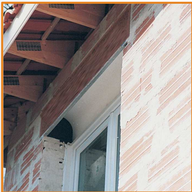
Dans un coffre tunnel
